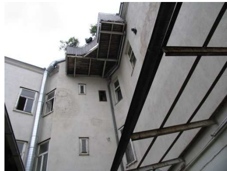
Hoffassaden Süden und Osten
